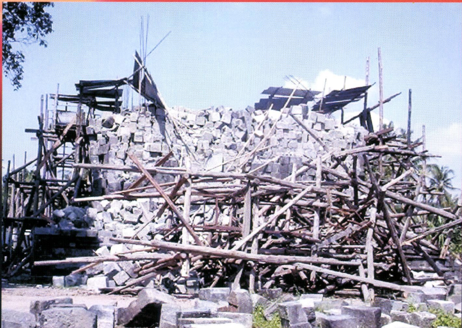
KONDISI BANGUNAN SISI UTARA
