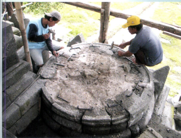
Pembuatan Angkur Sebagai Perkuatan Antar Batu Bagian Stupa
