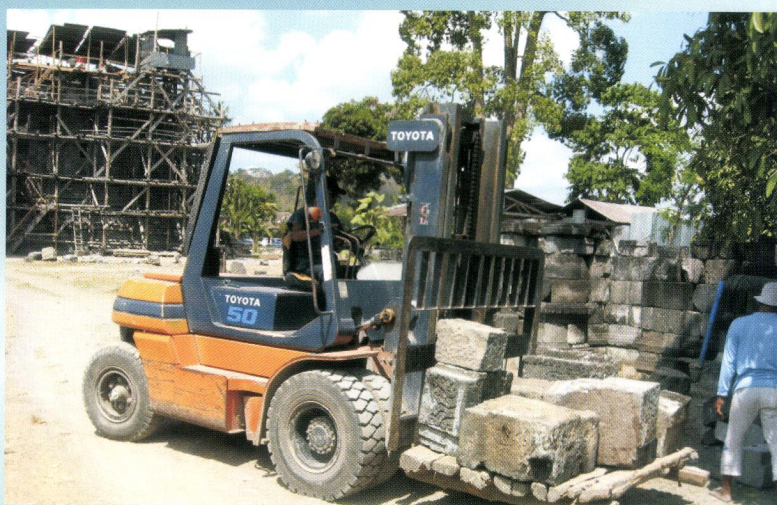
Pengangkutan Batu Menggunakan Forklift
