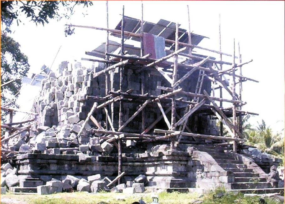
KONDISI BANGUNAN SISI BARAT
