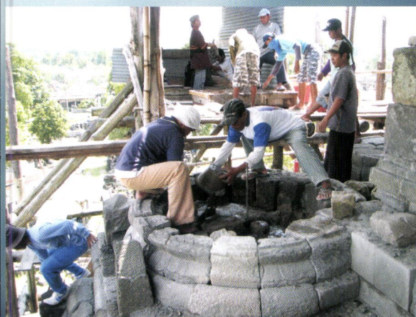
Perkuatan Batu Isian Bagian Stupa dengan PC
