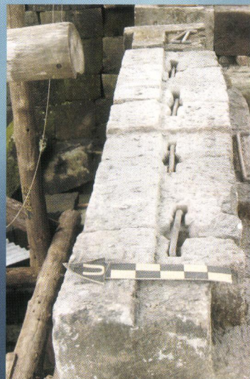
Teknik Perkuatan antar batu dengan angkur besi
