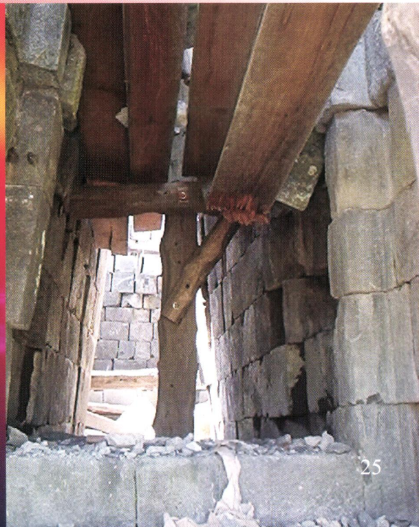
Dinding Pintu Miring dan Menyempit
