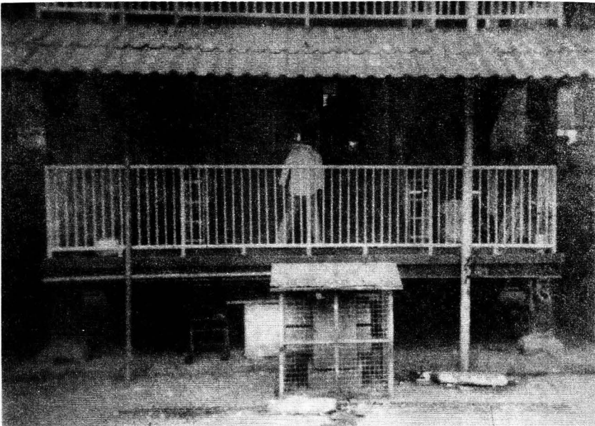
Gambar 3. Tangga Tempat Naik dan Turun Warga Rumah Susun di Salah Satu Kelompok Rumah Susun Kebon Kaang
