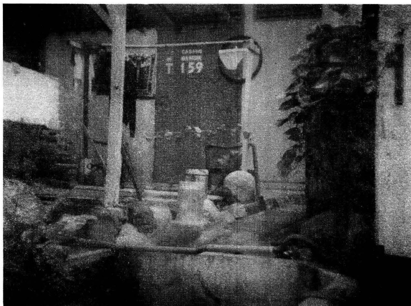
Gambar 9 Gardu Listrik yang terdapat di Komplek Rumah susun Kebon Kacang
