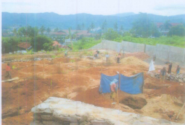
Pembangunan Gedung Tahap I
