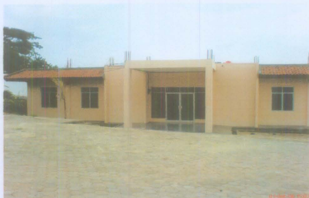
Pembangunan Gedung KBPL Tahap II
