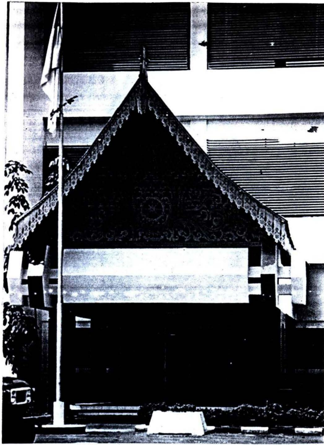
Gambar Gedung Depperindag Sumatera Utara Jl. Putri Hijau Medan
