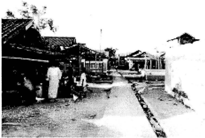
Photo 3.5 Gang / ruas jalan di antara rumah penduduk yang telah diperkeras dengan adukan semen
