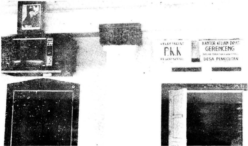
Gambar 25 Bagian belakang dari bangunan utama Bale Banjar Gerenceng yang digunakan untuk kantor administrasi dan sekretariat PKK. Fungsi tambahan dari bangunan Bale Banjar untuk kelancaran tugas administrasi banjar.
