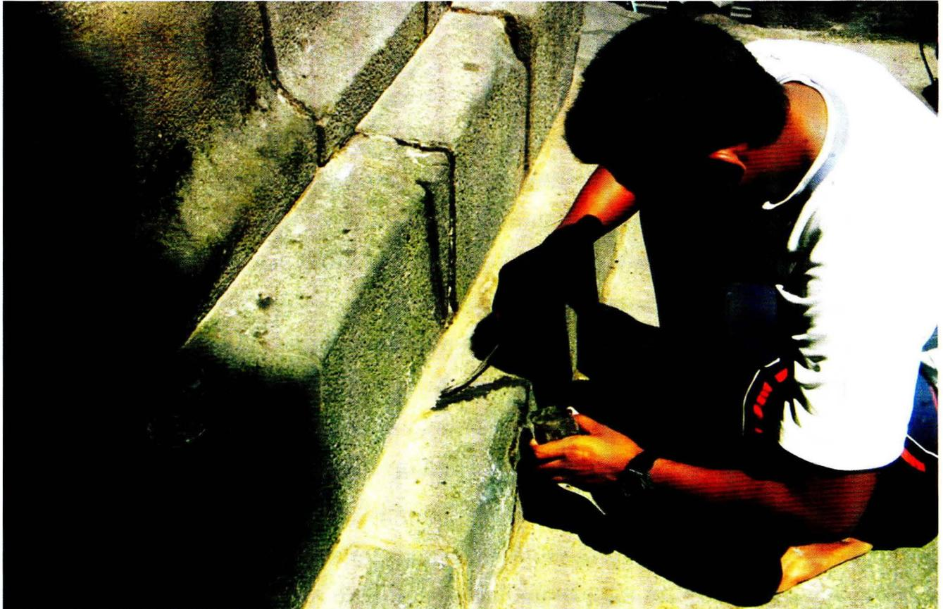
Proses kegiatan kamuflase (penyelarasan) batu setelah dilakukan pengolesan *epoxy resin*
