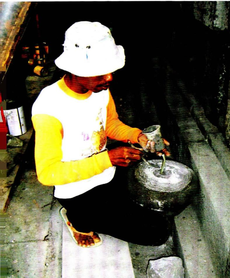
Proses kegiatan pemasangan angkur pada pinakel *ratna* langkan yang diperkuat dengan *epoxy resin*
