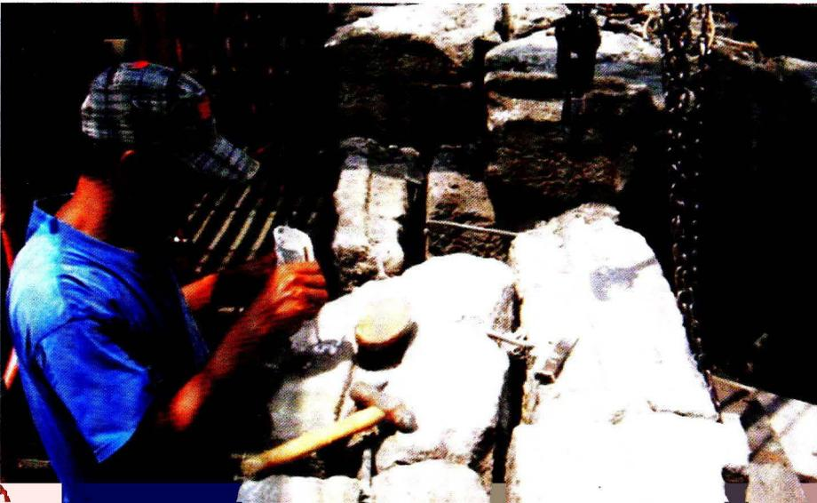
Proses kegestrasi batu dalam rangka identifikasi sebelum dilakukan pembongkaran
