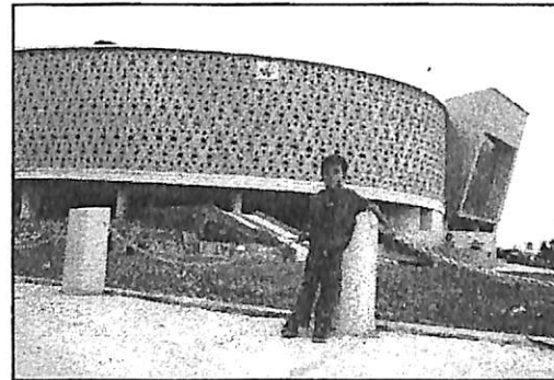
Gambar: Ruang publik di sekitar bangunan Museum Tsunami yang tampak akrab dipakai oleh masyarakat, merupakan hal yang positif untuk mengenal maksud bangunan ini lebih jauh.
