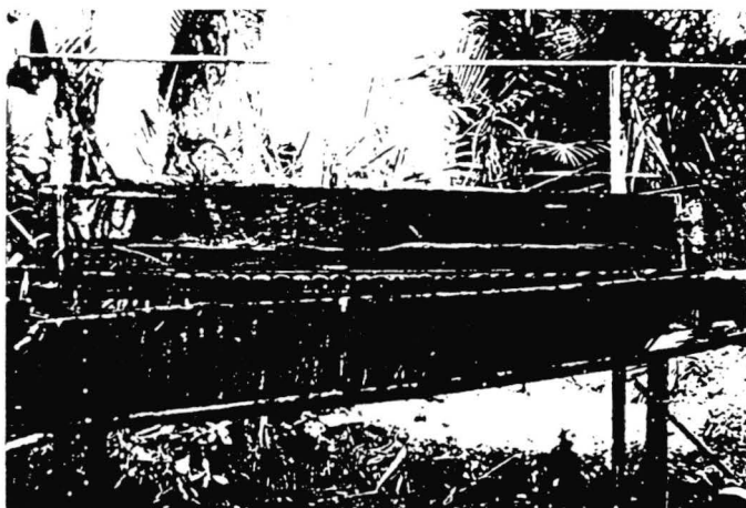
Gambar 28. Di bawah kotak kayu diletakkan penampang untuk mengalirkan tepung sagu yang turun bersama air yang terbuat dari anyaman daun sagu.
