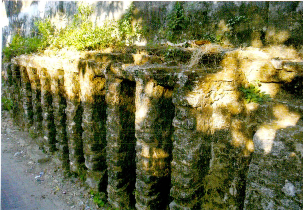
Tembok keraton sebelah barat
