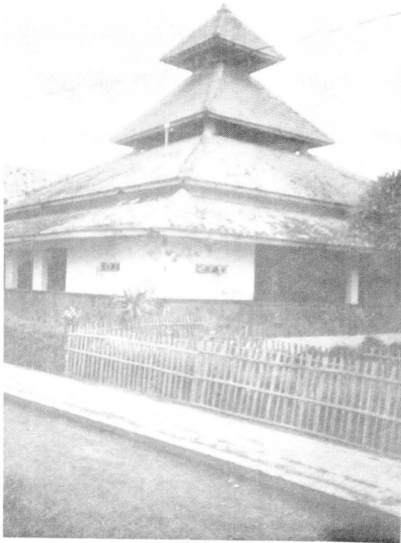
Atap tumpang Mesjid Pangeran Aria Sinaraja (tampak barat laut)
