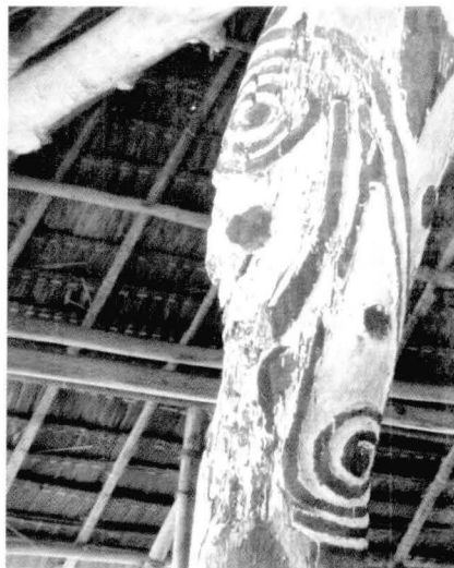
Gambar 61: Fouw Obonime pada tiang kombo Ifale
