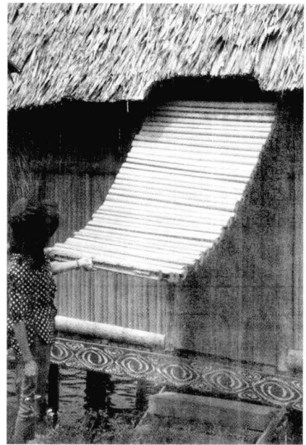
Gambar 36: Daun pintu dari pelepah sagu
