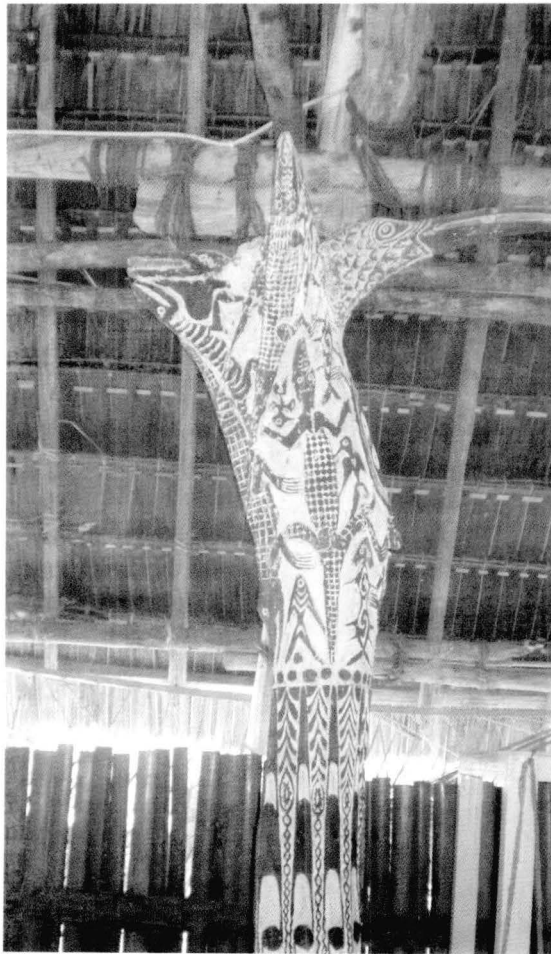
Gambar 41: Kayu pengikat atau abondai berjumlah delapan pada sekeliling bangunan.
