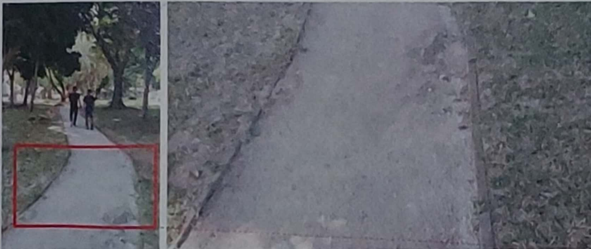
Contoh penggunaan konstruksi jalan setapak dengan bahan bubuk kapur karang dan pasir yang dipadatkan, digunakan di kompleks Protestant Cemetery George Town, Penang-Malaysia.
