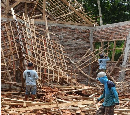
Gambar 10. Struktur Atap Ruang Kelas Roboh di SMK Baitul Hikmah Cibalong Kab. Garut, Tahun 2017 (Saat Pembangunan)
