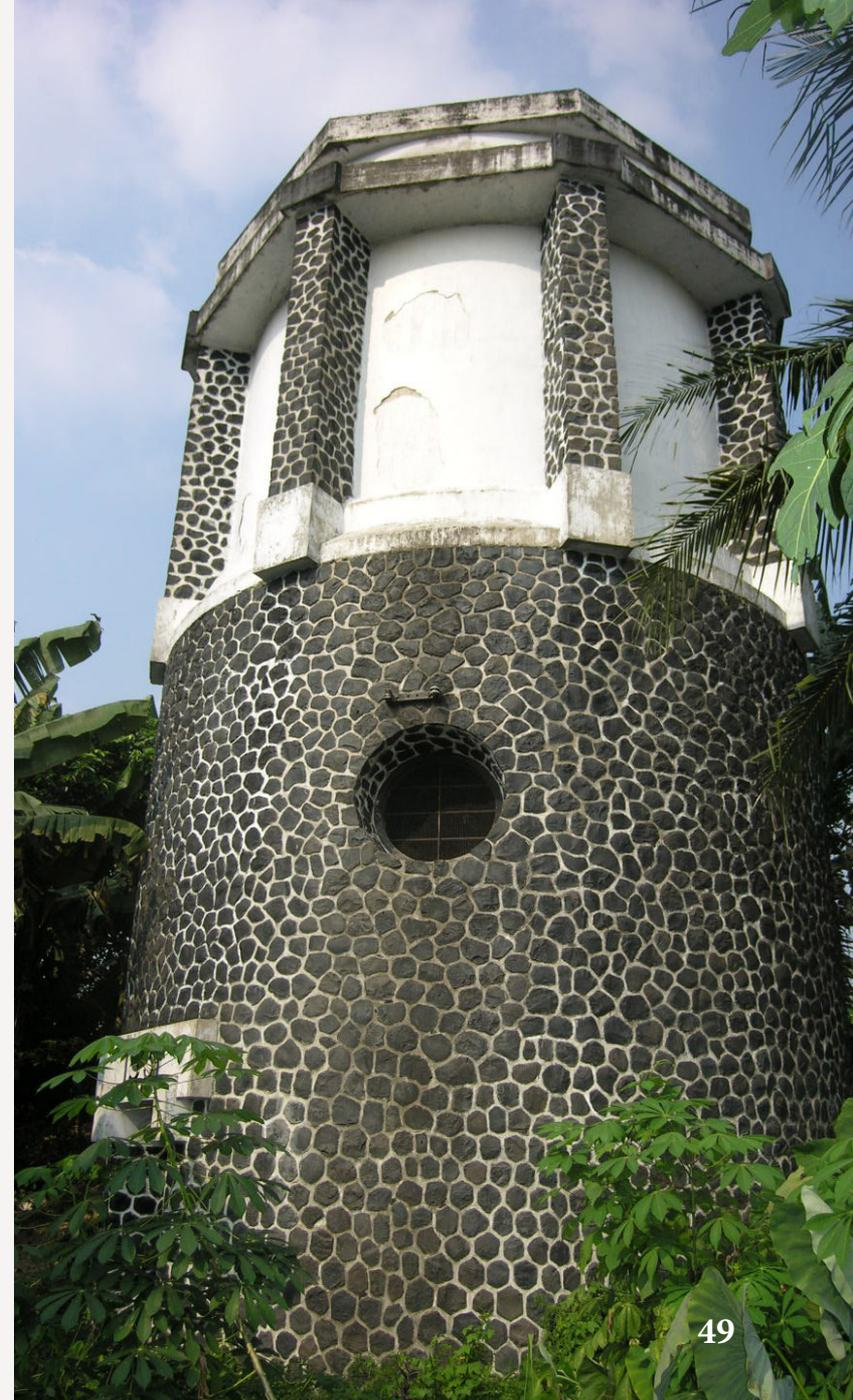
membangun prasarana sistem penyediaan air bersih untuk wilayah Rangkasbitung dengan mendirikan menara air. Menara air ini dulunya digunakan sebagai bak penampung atau reservoir, yang berfungsi sebagai penampung atau penyimpan air. Sumber air bakunya langsung berasal dari mata air Ciwasiat di lereng Gunung Pulosari (Pandeglang). Menara air ini merupakan bagian dari pengelolaan distribusi air untuk masyarakat Rangkasbitung.
