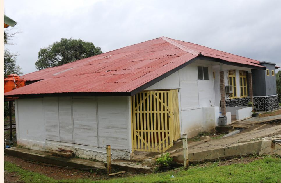
perisai, dengan penutup atap berupa seng. Arah hadap bangunan ke timur laut. Dinding bangunan bagian luar terdapat *stone masonry*, adapun dinding bagian tengah hingga ke atas berupa papan kayu yang disusun secara horisontal. Terdapat dua jenis penutup lantai bangunan, yaitu ubin berwarna abu-abu dan hitam berukuran 20 x 20 cm serta ubin keramik berwarna putih berukuran 30 x 30 cm.
