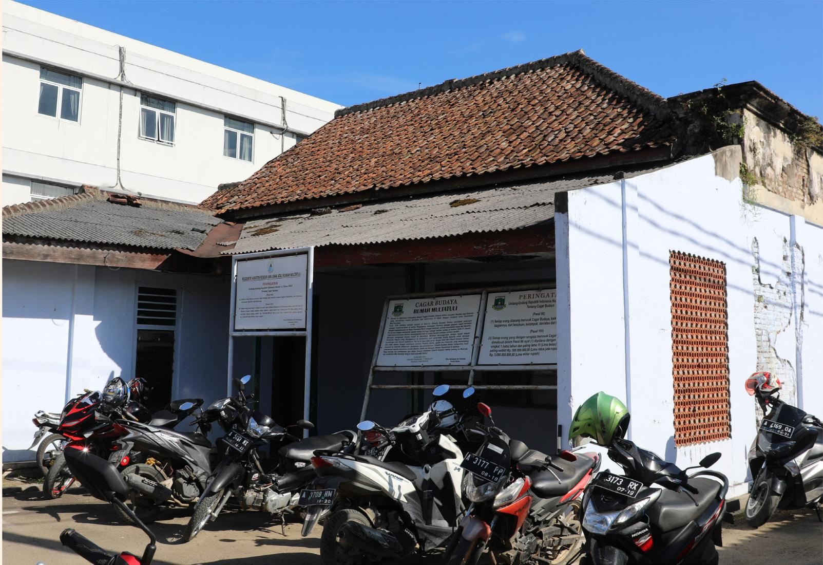
Bangunan bersejarah tersebut meninggalkan sedikit dinding lama, yang terletak di sisi utara bangunan, dengan panjang ± 891 cm. Pada sisa dinding tersebut terdapat profil berbentuk pelipit di bagian atas, serta pilar semu yang tampak di bagian luar dinding lama.
