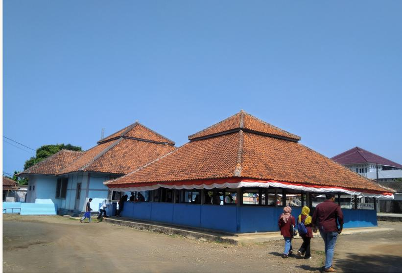
bertingkat. Penutup lantai sudah diganti dengan keramik, hanya menyisakan tegel lama di pinggir-pinggir pendopo. Pendopo dengan bangunan utama dihubungkan oleh koridor. Bangunan utama berdenah persegi dengan penambahan ruang di sisi timur dan selatan bangunan. Dinding bangunan berupa tembok tipis dengan rangka kayu vertikal dan horisontal di setiap sisinya. Akses pintu utama sudah diganti dengan pintu kaca dengan rangka aluminium.
