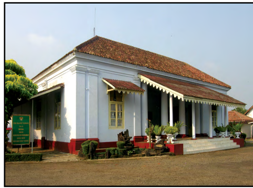
Bangunan KODIM 0601 Pandeglang
