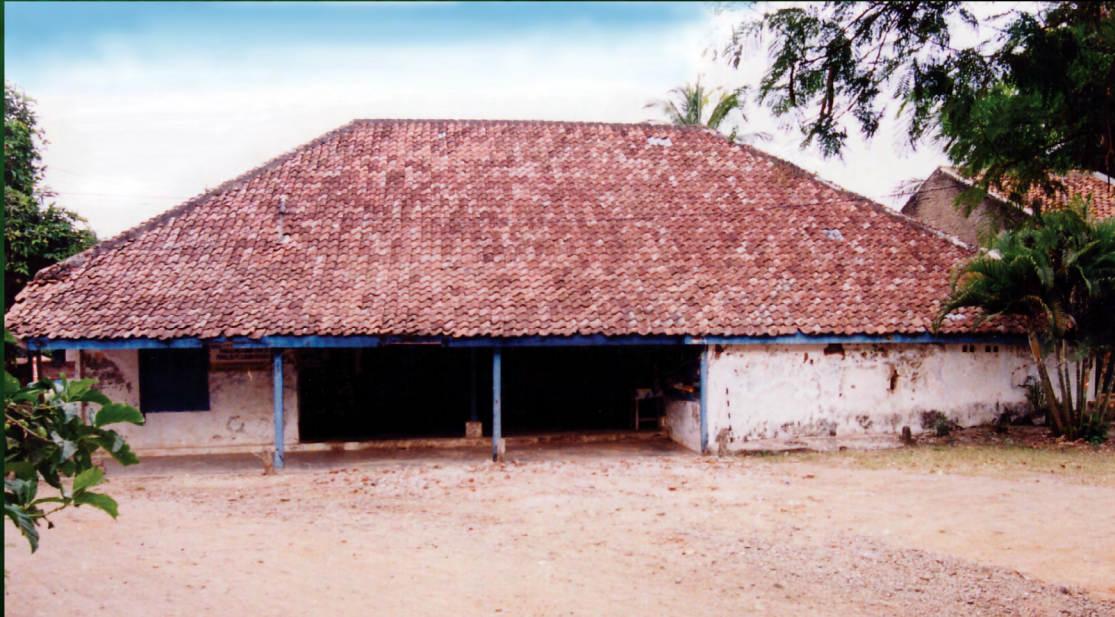
Bangunan tempat penyimpanan garam
