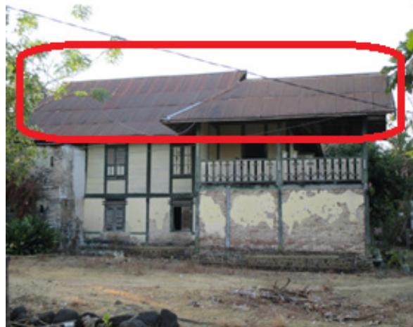
Gambar 7. Istana (Sauraja) Pattojo yang mengalami perubahan pada bagian atap
