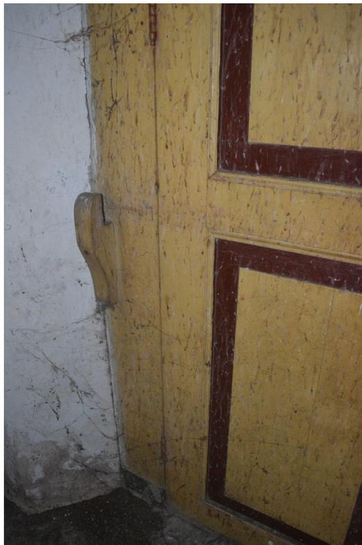
Gambar 3. Sisa penopang balok pengunci pada pintu
