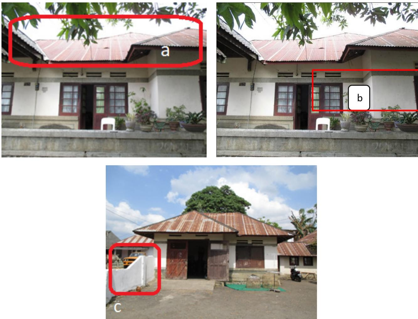
Gambar 3. a) Bagian atap yang diganti dengan seng. b) Tambahan bangunan pada bagian teras, c) Pagar
