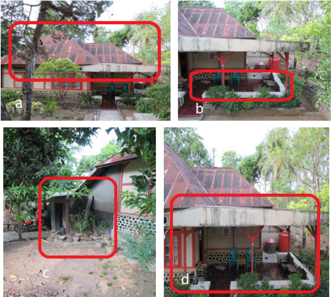
Gambar 2. a) Bagian atap yang sudah diganti dengan seng. b) Bagian lantai yang diganti dengan keramik, c) Penambahan bangunan pada bagian dapur, d) Penambahan bangunan pada bagian teras. (Sumber: Dok. Dewi Susanti, 2014)
