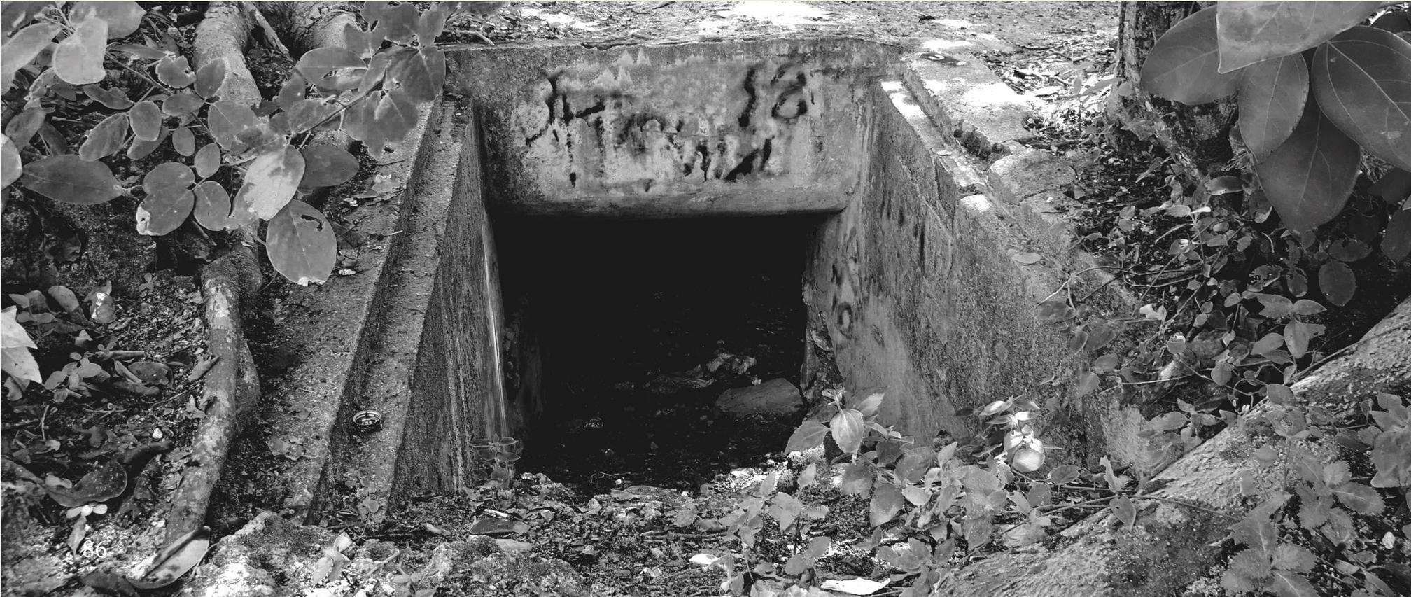
terdapat lubang pengintai menghadap ke arah barat laut (ke arah Pantai Pasir Putih). Untuk memasuki bunker, terlebih dahulu melalui parit yang ada di depannya. Konstruksi bunker terbuat dari coran pasir, koral dan kapur.
