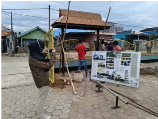
Foto 3.3 Proses pemasangan papan informasi. (Dok. BPCB Kalimantan Timur 2020)
