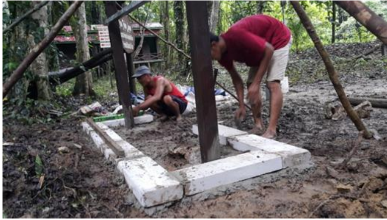
Foto 3.12 Proses pembuatan bagian dasar papan informasi. (Dok. BPCB Kalimantan Timur 2020)
