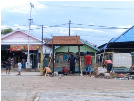
Foto 3.1 Proses pendirian tiang papan informasi. (Dok. BPCB Kalimantan Timur 2020)
