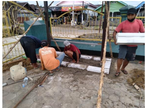
Foto 3.2 Pengerjaan bagian dasar dan pondasi. (Dok. BPCB Kalimantan Timur 2020)
