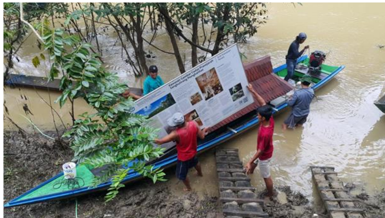
Foto 3.10 Proses pengangkutan bahan dan material ke atas perahu menuju Tepian Tewet. (Dok. BPCB Kalimantan Timur 2020)
