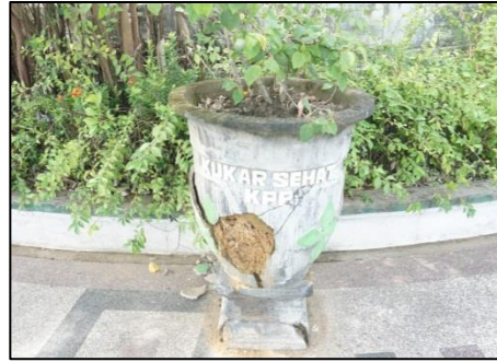
Foto III-12 Pot Bunga yang rusak/pecah di sisi Barat. (Dok. BPCB Kalimantan Timur. 2020)
