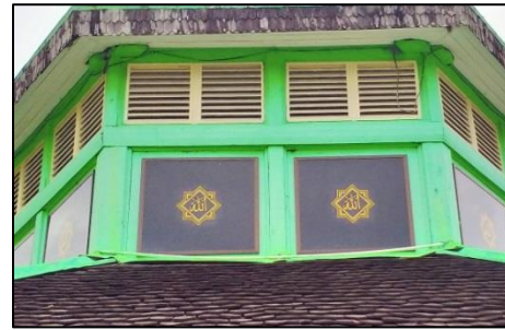
Foto II-24 Jendela mati berbahan kaca pada Mihrab Masjid Jami Amir (Dok. BPCB Kalimantan Timur. 2020)
