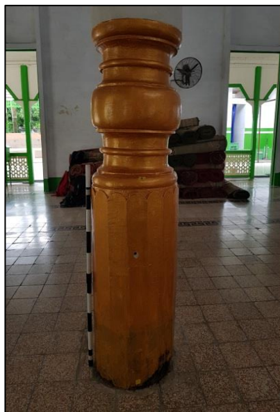
Foto III-18 Kondisi kolom tampak dari sisi barat (Dok. BPCB Kalimantan Timur. 2020)
