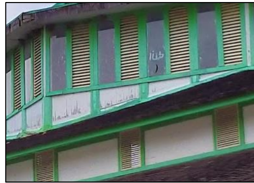
Foto II-25 Jendela kayu mati pada dinding 2 (bawah) dan dinding 3 (atas) di Masjid Jami' Adji Amir Hasanoeddin tampak dari dalam (kiri) dan dari luar (kanan) (Dok. BPCB Kalimantan Timur. 2020)
