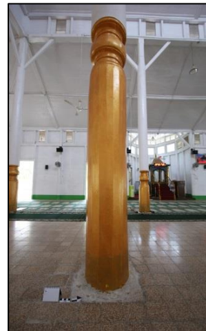
Foto III-33 Kondisi Kolom TU. M. 31 dari sisi timur (Dok. BPCB Kalimantan Timur. 2020)
