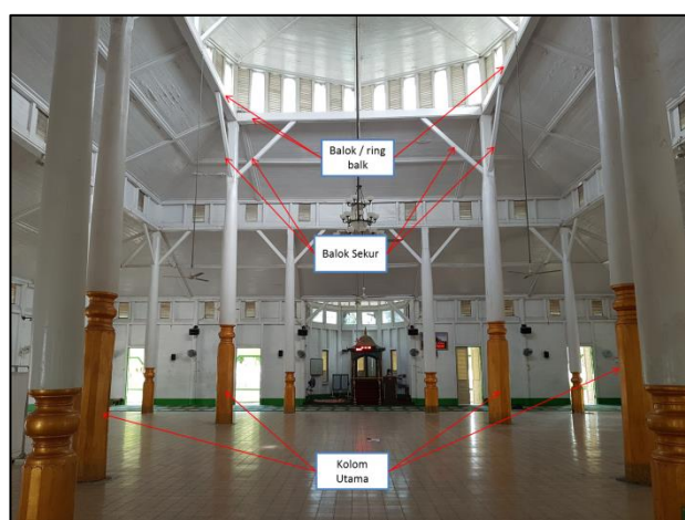
Foto II-12 Struktur kolom utama (Dok. BPCB Kalimantan Timur. 2020)
