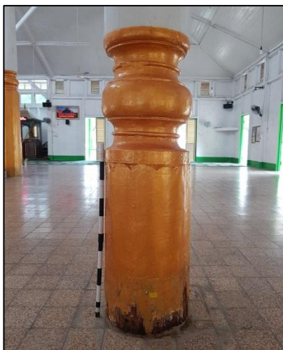
Foto III-19 Kondisi kolom TU. m. 18 dari sisi timur (Dok. BPCB Kalimantan Timur. 2020)
