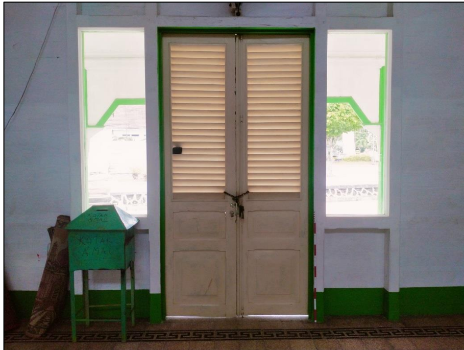
Foto II-18 Pintu Utama dan Jendela Cahaya Masjid Jami' Adji Amir Hasanoeddin tampak dari dalam (Dok. BPCB Kalimantan Timur. 2020)
