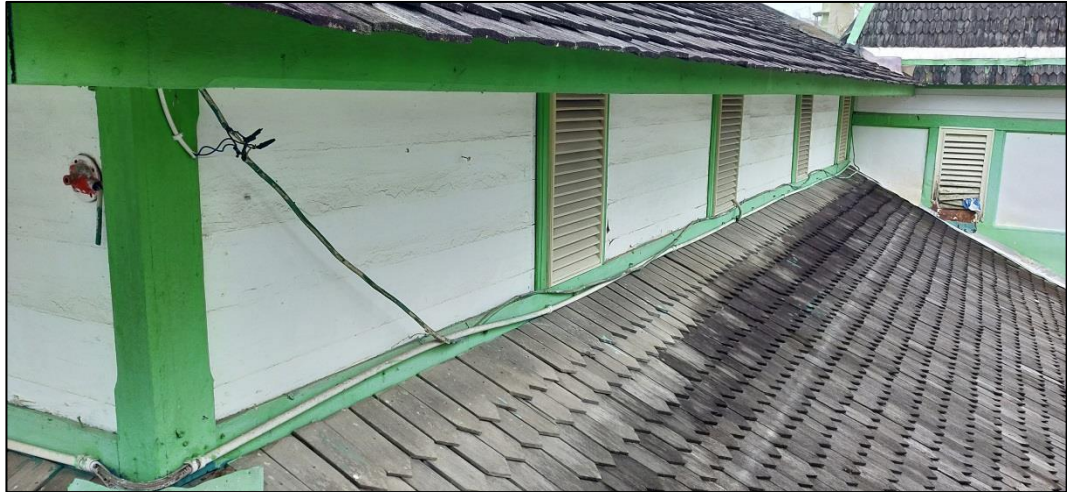
Foto II-22 Jendela pada dinding 1 di atas atap 1 (Dok. BPCB Kalimantan Timur. 2020)
