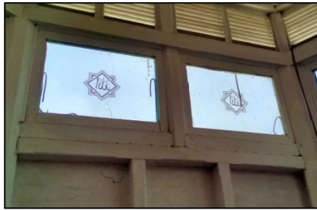
Foto II-24 Jendela mati berbahan kaca pada Mihrab Masjid Jami Amir (Dok. BPCB Kalimantan Timur. 2020)
