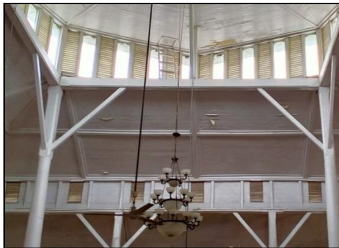
Foto II-25 Jendela kayu mati pada dinding 2 (bawah) dan dinding 3 (atas) di Masjid Jami' Adji Amir Hasanoeddin tampak dari dalam (kiri) dan dari luar (kanan) (Dok. BPCB Kalimantan Timur. 2020)
