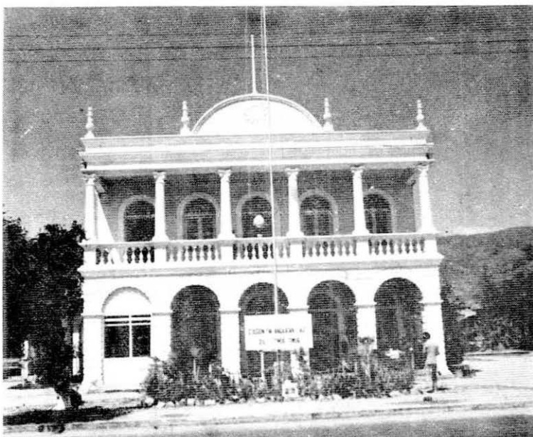
Foto 9 Bangunan Tua, Stasiun TNI Angkatan Laut, Dili
