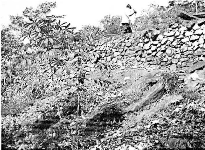
Pola susunan balok batu penyusun dinding teras dengan pola membujur dan melintang mengikuti kemiringan lahan dinding teras dinding ters 2 sisi sebelah tenggara
