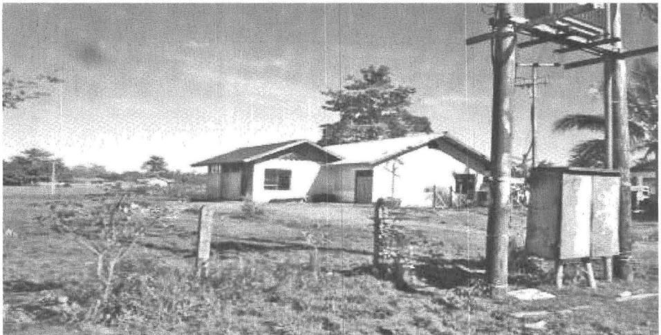
Gambar 5. Keadaan Bangunan PDAM
