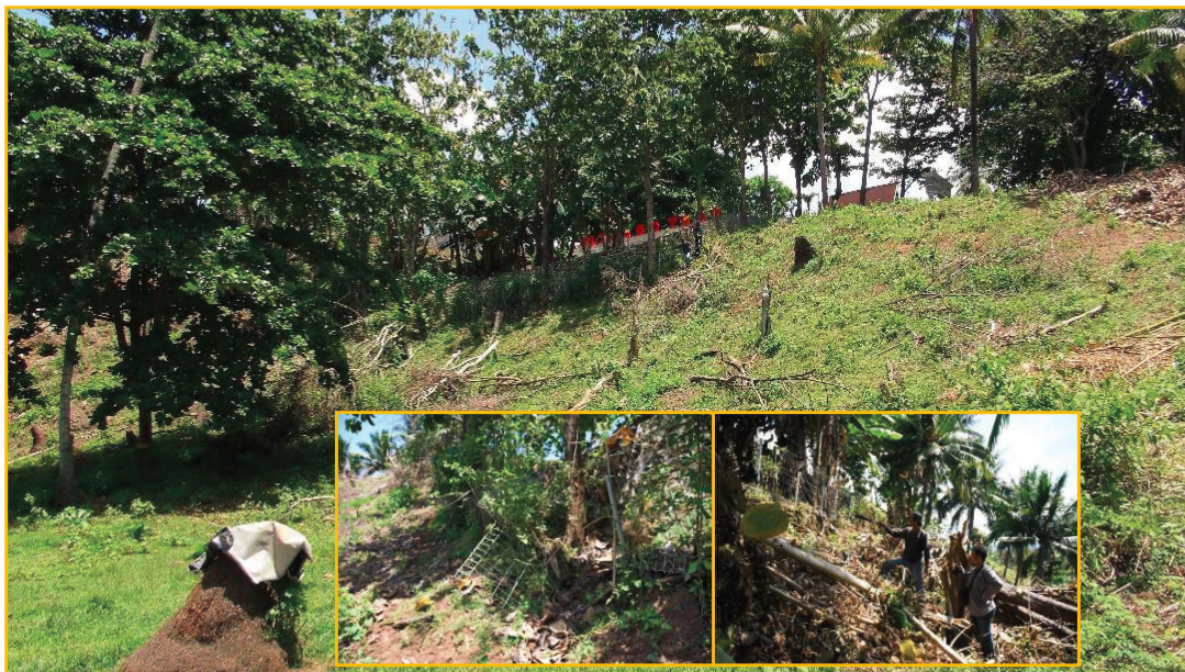
Foto 3. Potensi gerakan tanah di lereng barat Benteng Orange, Kwandang, Gorontalo Utara. Lereng tampak aman dan stabil, tapi tanda-tanda gerakan tanah terlihat dari bergesernya pondasi pagar dan struktur bastion. (Sumber: BPCB Gorontalo, 2018)
