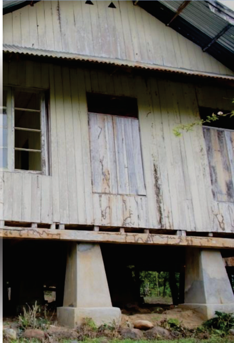
Gambar 4. Serangan rayap pada sisi utara bangunan (Dokumentasi: BPCB Gorontalo Tahun 2020)
