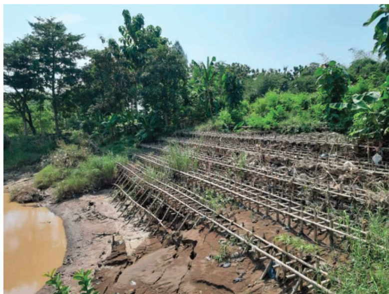
Foto 4. Panel bambu merupakan penahan erosi ramah lingkungan. (Sumber: Balitbang PUPR, 2013)
