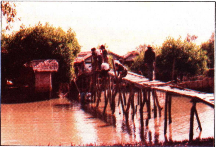
Jiwa persatuan tercermin dalam gotong royong memperbaiki jembatan
