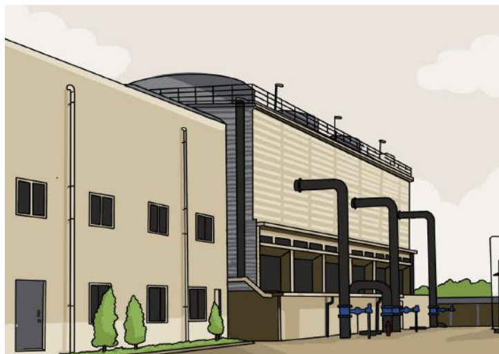
Pipa penyalur gas buang pembakaran sampah di PLTSa Benowo.
