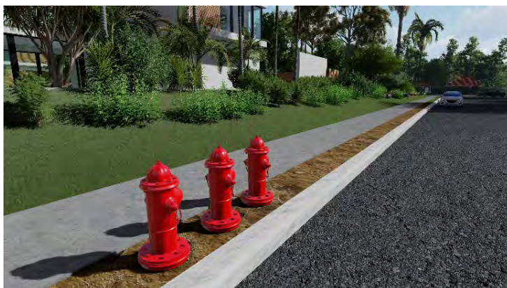
Gambar 9. Ilustrasi penempatan pipa hydrant di jalan
