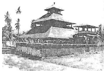
dan dihubungkan dengan balok penahan kuda-kuda. Pada sisi luar *soko guru* terdapat 12 buah tiang yang mendukung atas *undak* ke-2. pada bagian luarnya terdapat 20 buah tiang yang berfungsi sebagai pendukung kerangka atap *undak* pertama. Tiang-tiang pada bagian sisi luar dihubungkan dengan papan yang berfungsi sebagai pendukung kerangka atap *undak* pertama. Tiang-tiang pada bagian sisi luar dihubungkan dengan papan yang berfungsi sebagai pengikat tiang satu dengan tiang yang lain.
