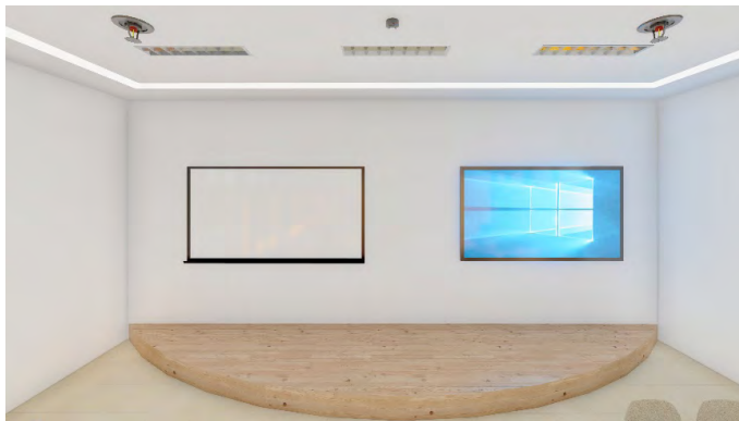
Gambar 12. Ilustrasi pemasangan smoke detector dan sprinkler
