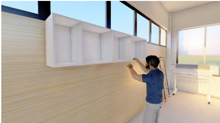
Gambar 4. Ilustrasi pengangkuran lemari
