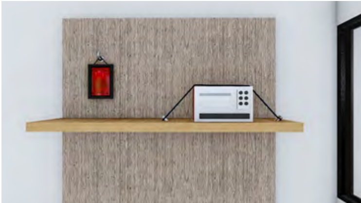
Gambar 7. Komponen non-struktur harus diberi pengaku
