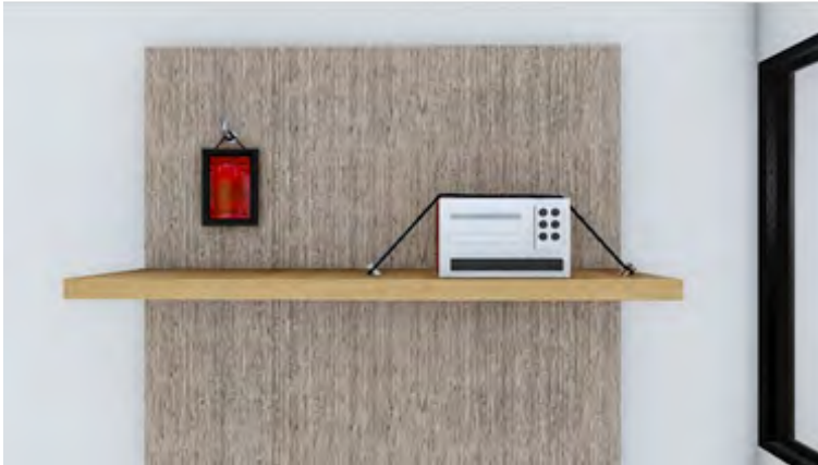
Gambar 7. Komponen non-struktur harus diberi pengaku
