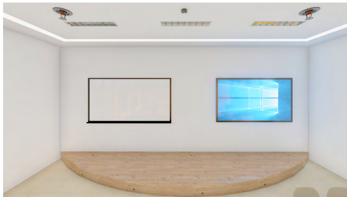
Gambar 12. Ilustrasi pemasangan smoke detector dan sprinkler .
