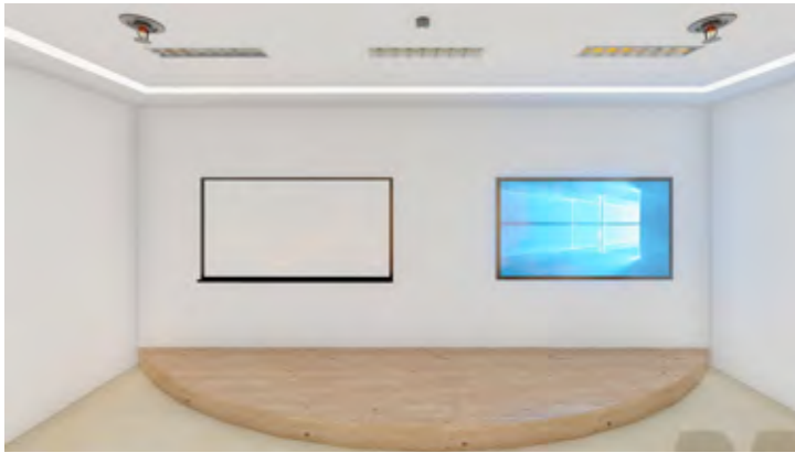
Gambar 12. Ilustrasi pemasangan smoke detector dan sprinkler
