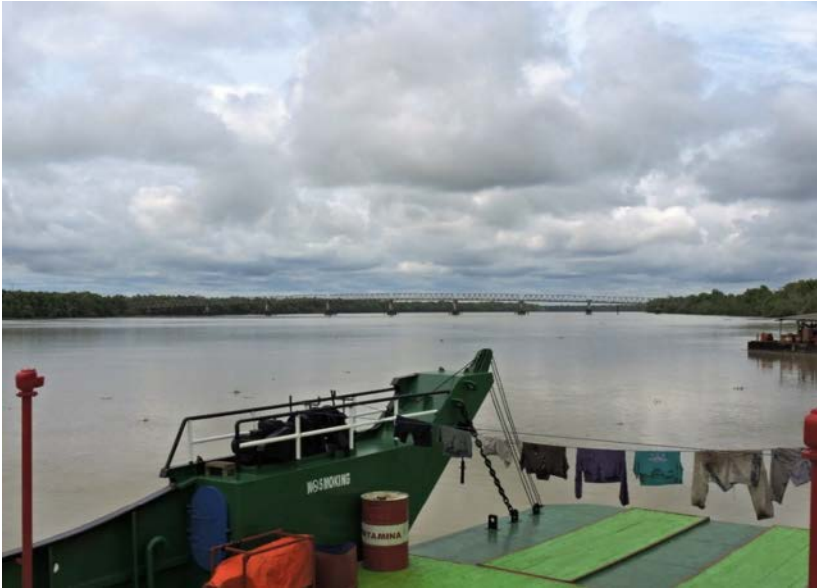
Jembatan Tujuh Wali-Wali menghubungkan dua sisi Sungai Maro
