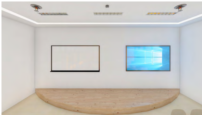
Gambar 12. Ilustrasi pemasangan smoke detector dan sprinkler
