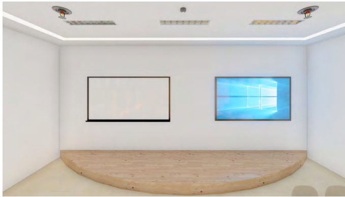
Gambar 12. Ilustrasi pemasangan smoke detector dan sprinkler
