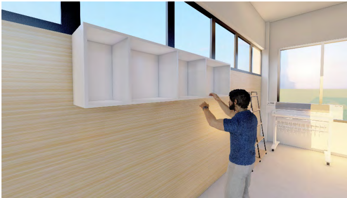
Gambar 4. Ilustrasi pengangkuran lemari
