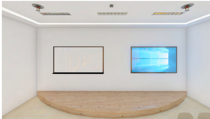
Gambar 12. Ilustrasi pemasangan smoke detector dan sprinkler .
