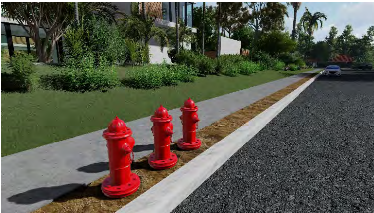
Gambar 9. Ilustrasi penempatan pipa hydrant jalan
