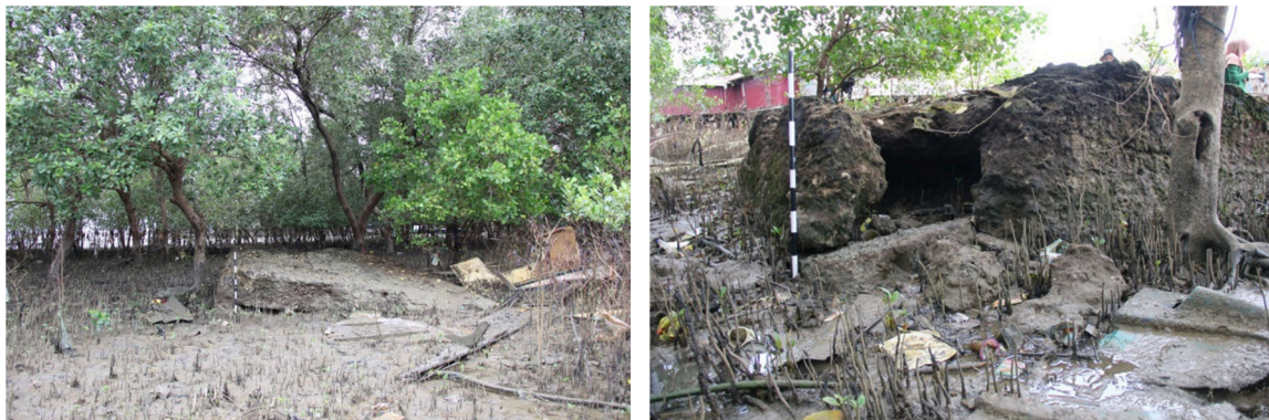
Kondisi Bunker yang saat ini terendam lumpur (Dok. BPCB Kalimantan Timur)
