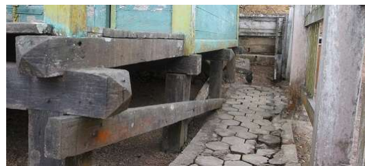
Foto 2.4 Kondisi Tiang Pondasi (Dok. BPCB Kalimantan Timur 2019)
