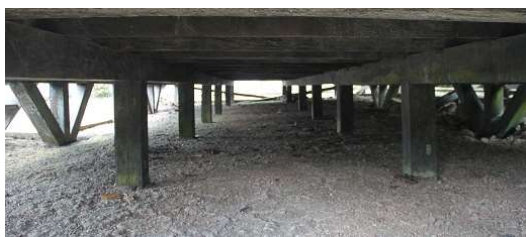
Foto 2.4 Kondisi Tiang Pondasi (Dok. BPCB Kalimantan Timur 2019)
