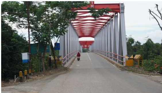
Foto 2.1 Jembatan Sanga-sanga (Dok. BPCB Kalimantan Timur 2019)
