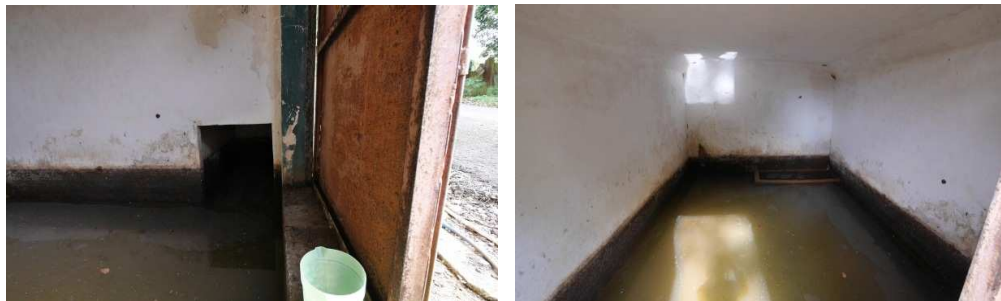
Foto 3.6 Kondisi Pos Komando sebelum dilakukan pembersihan, perbaikan dan pengecatan
