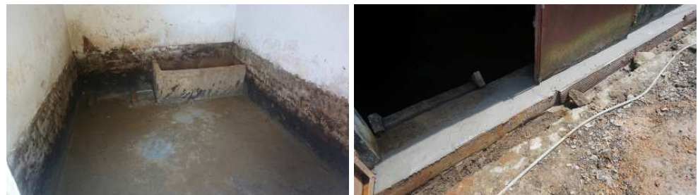
Foto 3.16 Pekerjaan pengecoran lubang lantai dan pembuatan tanggul
