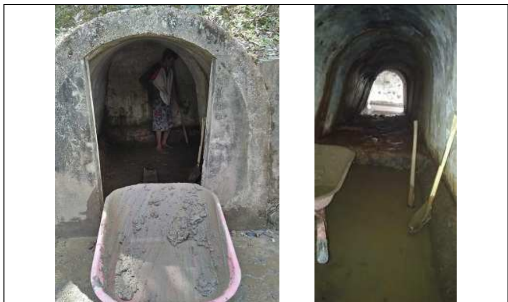
Foto 3.17 Pekerjaan pengurasan air dan dan galian tanah dalam
