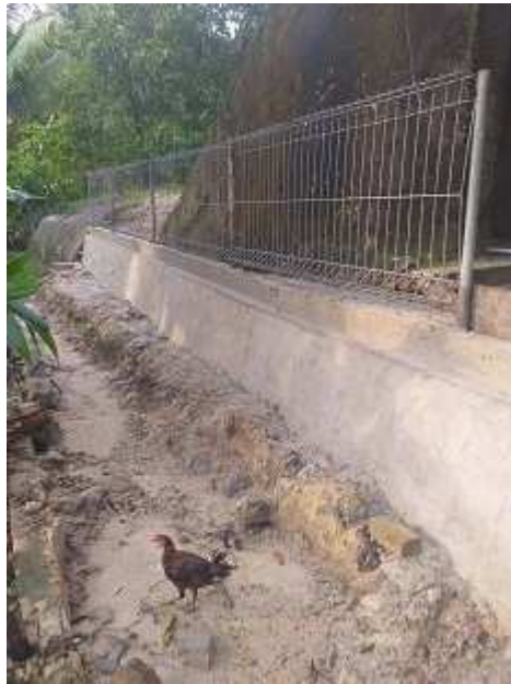
Foto 3.21 Pekerjaan pembuatan sloof beton bertulang pada Banker Ladang
