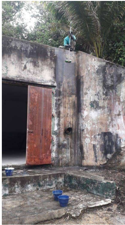
Foto 3.14 Pekerjaan pembersihan dan pengerokan dinding Gardu Listrik
