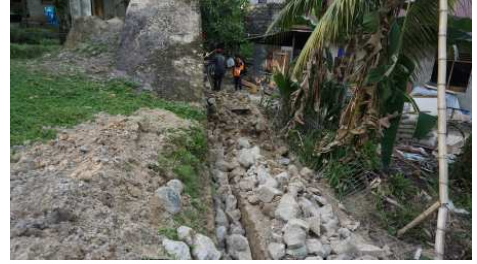
Foto 3.20 Pekerjaan galian dan pondasi pada Bunker Ladang
