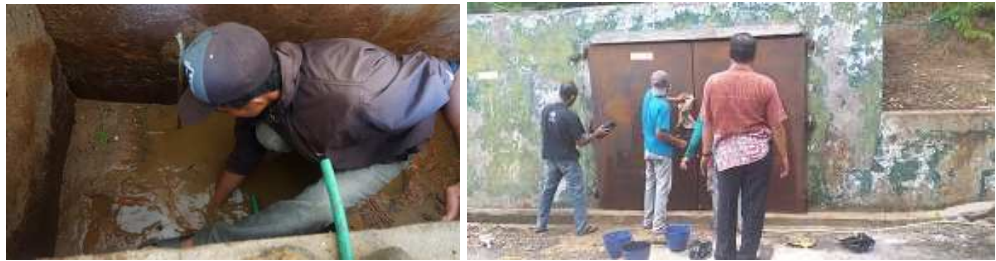
Foto 3.15 Pekerjaan pembersihan dan pengurasan pos komando
