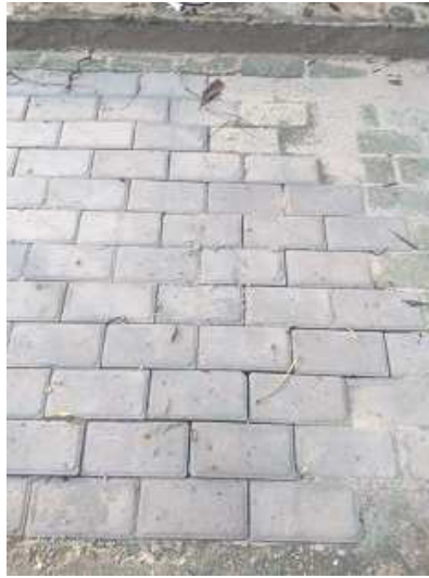
Foto 3.22 Pekerjaan pemasangan paving blok
