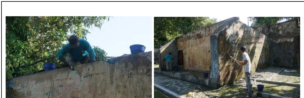
Foto 3.11 Pekerjaan pembersihan dan pengerokan dinding luar gudang logistik
