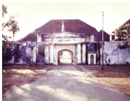
Pintu gerbang sebelah barat sebelum dipugar. Jembatan dan parit sudah tidak tampak lagi.
