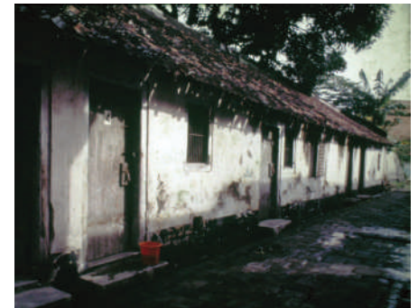
Bangunan L1 sebelum dipugar.
