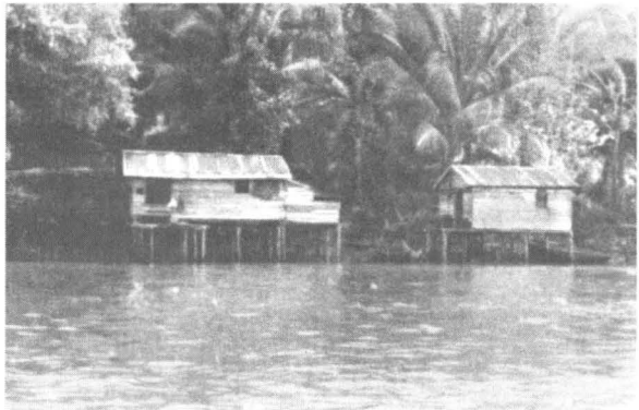
Rumah yang dibangun dengan posisi menyamping ke laut.
