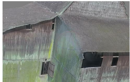
Gambar 8. Dalam permodelan 3 dimensi Rumah Adat Bubungan Tinggi Habirau, tampak bagian papan dinding sebelah kiri pada ruang panampik kacil bagian atas hilang, yang perlu dilakukan penggantian papan.
