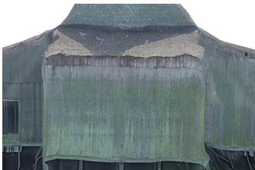
Gambar 10. Dalam permodelan 3D Rumah Adat Bubungan Tinggi Habirau, pada dinding kiri bangunan juga banyak ditumbuhi lumut dan terjadi aus (bagian atas) pada bahan bangunan. Hal ini dikarenakan tingginya tingkat kelembaban yang disebabkan padatnya rumah penduduk bahkan sangat dekat dengan bangunan tersebut.
