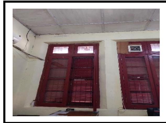
***FOTO HASIL KEGIATAN PERBAIKAN PLAFON DAN PENGGANTIAN KUSEN JENDELA GEDUNG I BENTENG ROTTERDAM***
