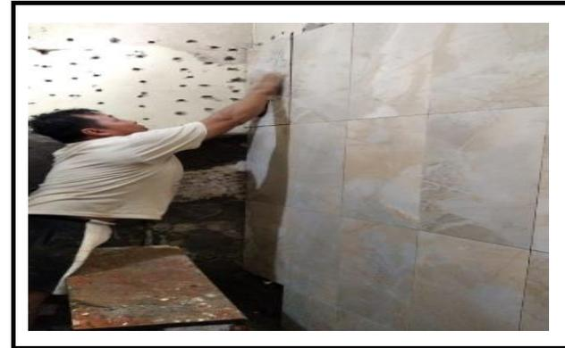
***FOTO KEGIATAN PEMASANGAN TEGEL KERAMIK LANTAI DAN DINDING GEDUNG I***
