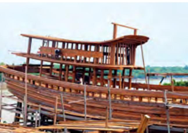
⚡ Bagian lambung kapal yang papan-papannya disambung dengan ribuan pasak kayu. Pasak-pasak tersebut harus dipasang dengan tepat. Jika pemasangan pasak dalam lambung “bertabrakan”, maka lambung perahu tidak akan kuat dan cepat bocor (atas). Buritan pada Pinisi pada umumnya digunakan sebagai tempat kemudi bawah. Pemasangan buritan dilakukan setelah semua papan tersusun. Bagian buritan berbentuk segitiga, yang di dalamnya terdapat bangunan beratap datar tempat kamar juru mudi (bawah).
