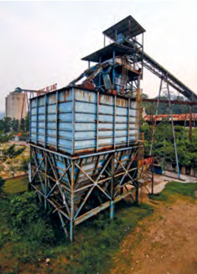
⚡ Penampakan *Sizing Plant* yang merupakan tempat beroperasinya mesin-mesin pencuci batubara dan mengelompokkannya, sebelum dikirim ke Silo untuk disimpan dan menunggu pengangkutan ke Pelabuhan Teluk Bayur.
