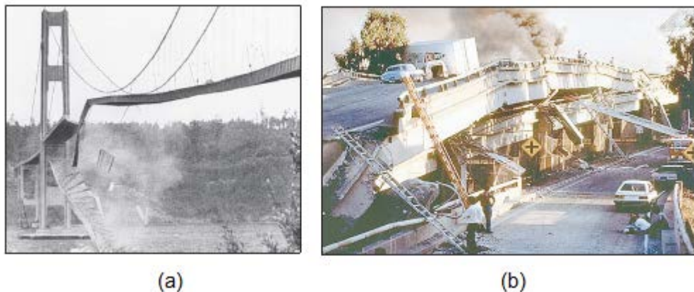
Gambar 1.5 (a) Osilasi dengan Amplitudo Besar pada Jembatan Tacoma Narrows, yang disebabkan angin ribut (b) Runtuhnya jalan bebas Hambatan di California yang Disrbabkan Gempa Bumi, di mana resonansi memainkan peranannya pada kedua kejadian tersebut
