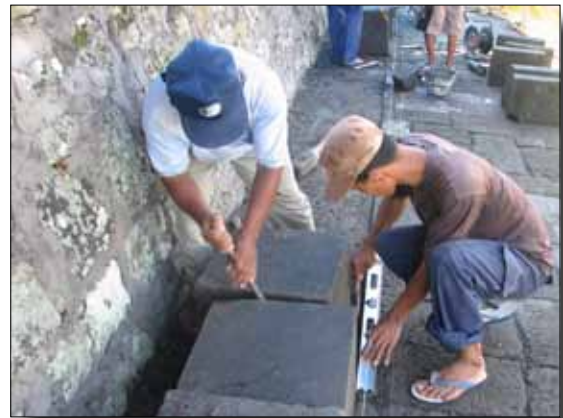
Penyusunan kembali batu dinding teras II
